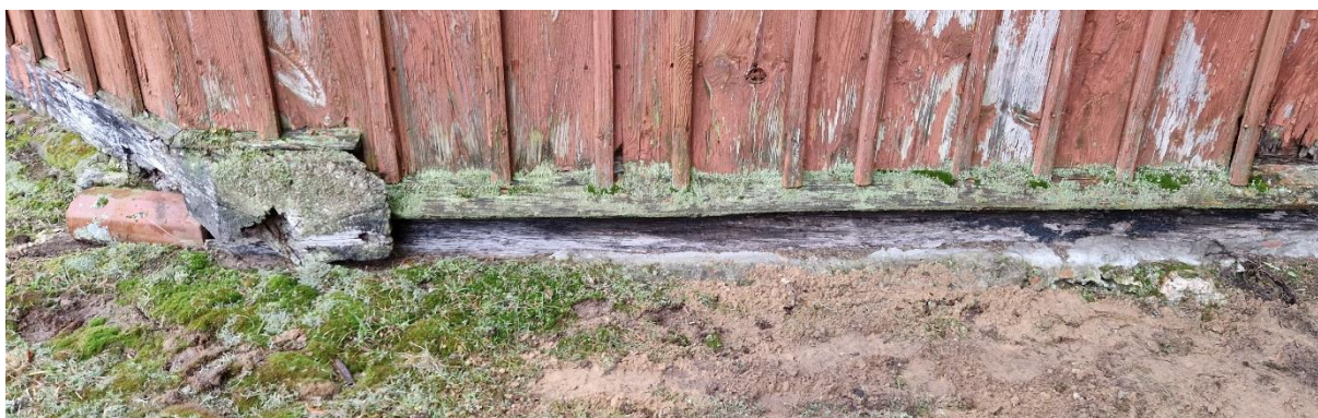
Fot. podwaliny cerkwi, stan zachowania 2024 r.
